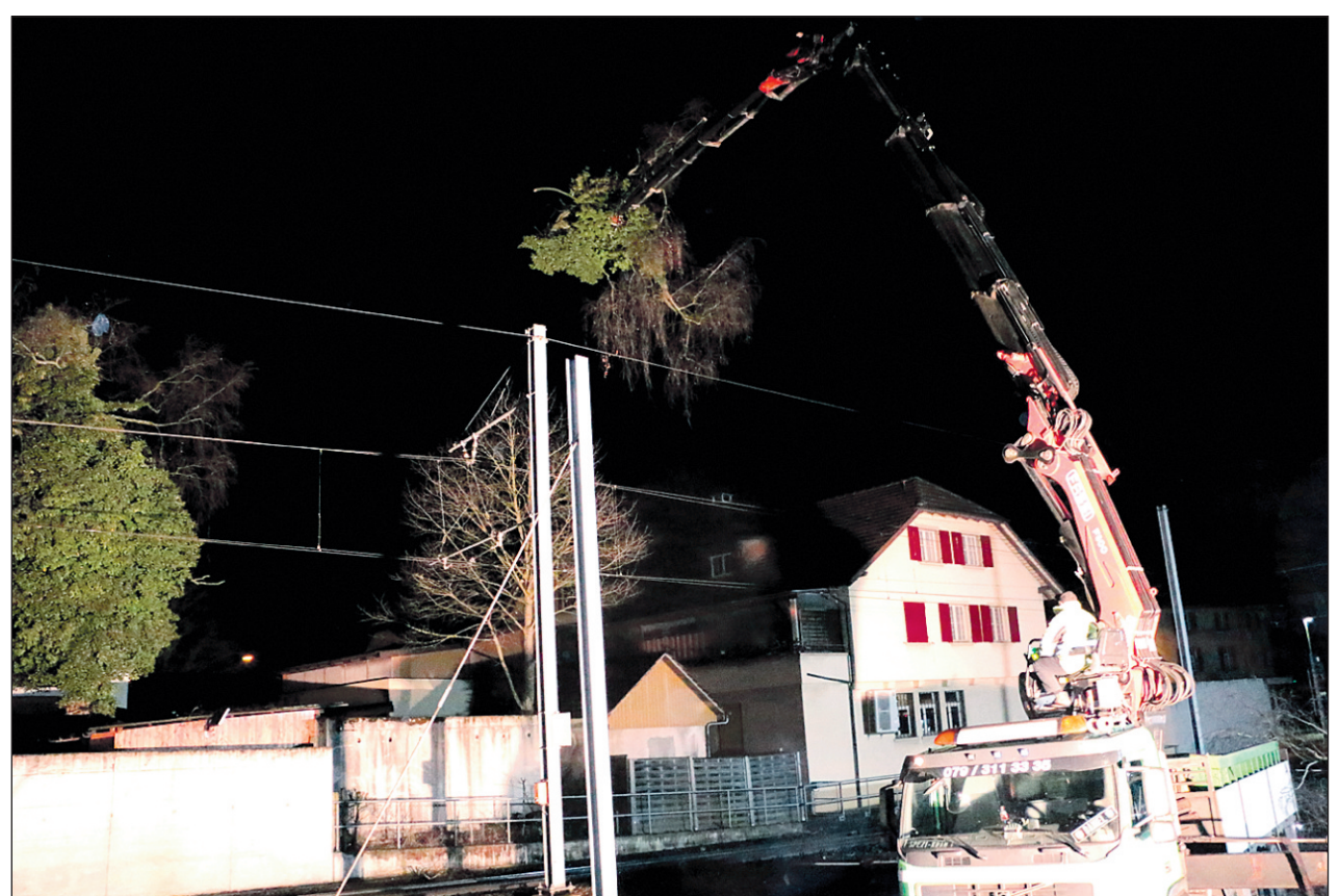
Der fast 24 Meter lange Arm ragt in den Nachthimmel: Der «Fassi F 800» hob die Birke in Einzelteilen über die Fahrleitungen der WSB. Auch der Bergahorn hinter den beiden Masten in der Bildmitte wurde vorsorglich gefällt. (Bilder: rc.)
